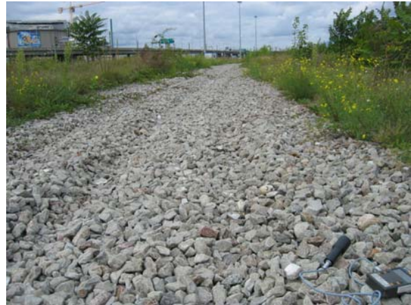
Trassee nach Norden
